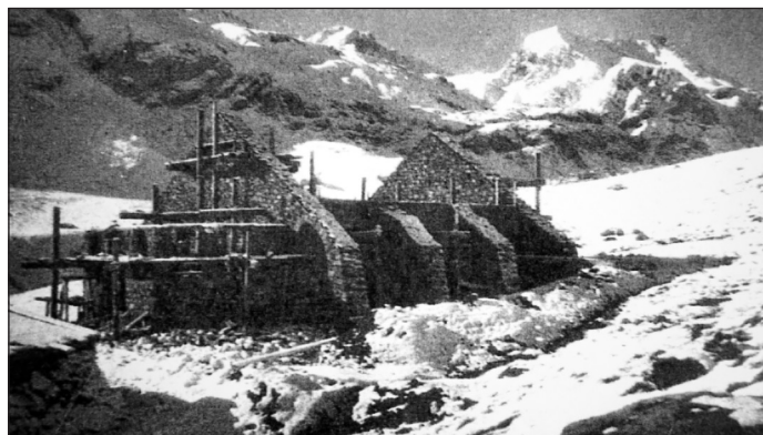
Figura 8. Construcción del refugio. Montañeros de Aragón 1929-1999 y siempre...
