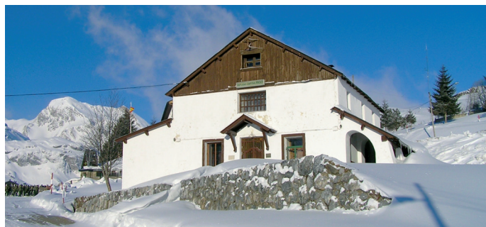
Figura 26. Estado actual del botiquín del acuartelamiento. Foto del autor.
