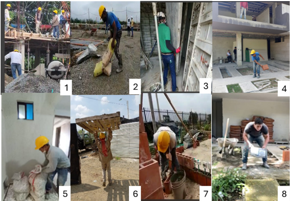
Figura 1. Tareas analizadas: 1. Paleado 2. Levantar bultos de cemento 3. Levantar formaletas 4. Levantar y lanzar ladrillos 5. Levantar bultos con piedra decorativa 6. Levantar estibas 7. Levantar ladrillos apilados 8. Levantar bultos de pegamento. Empresa de construcción, Cali (Colombia), 2023.
