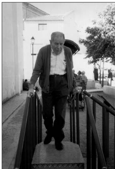
Fig. 8. Escaleras y rampa: suelo metálico antideslizante.
