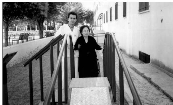
Fig. 7. Escaleras y rampa con barras asideras en todo su recorrido.
